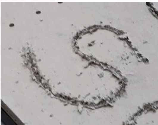
SCANALATURA CON UN CONVENZIONALE FRESA
